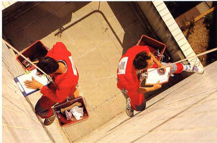
Du repérage photographique à la pose de joints, l'éventail des travaux est vaste.
